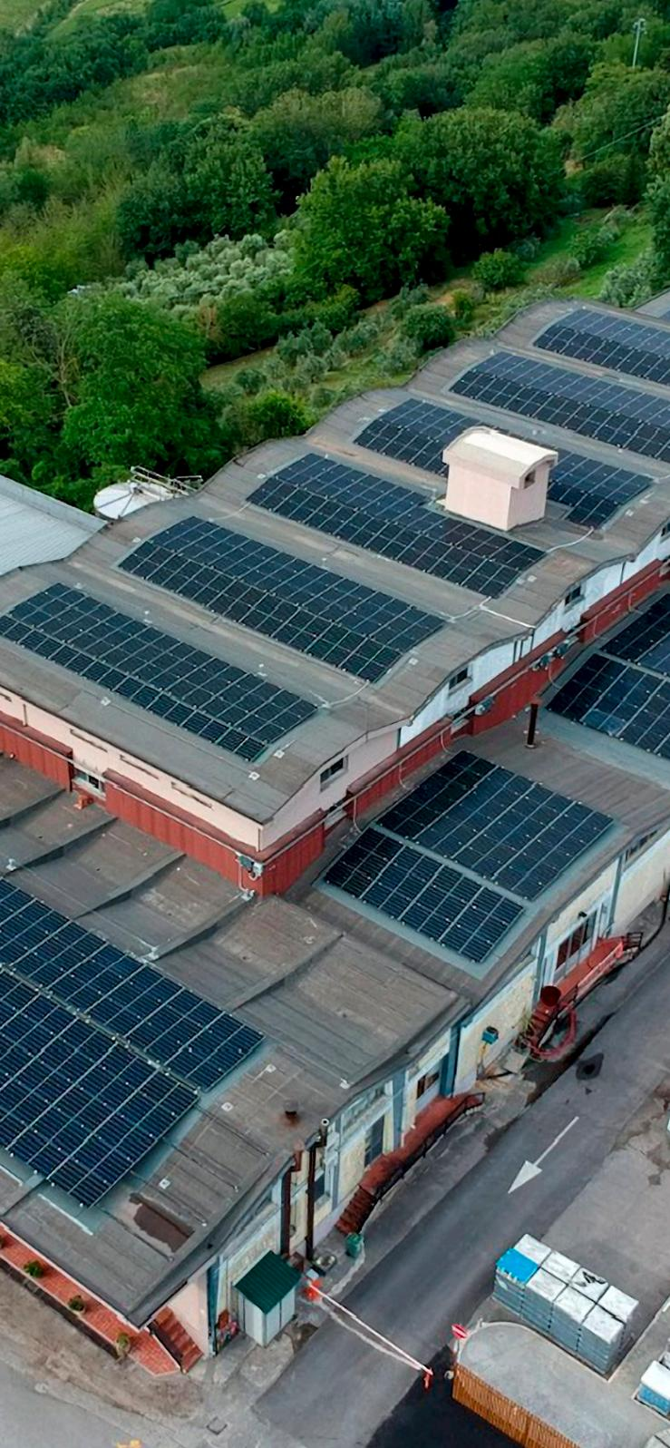
Nell'anno 2023 è stato realizzato un impianto fotovoltaico per una potenza pari a 280 kWp che sarà connesso in rete entro il mese di giugno 2024.
